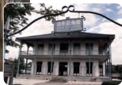
▲熊本地震(2016.4)で倒壊した*熊本洋学校教師館。
