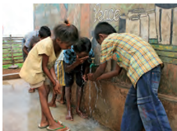
▲政府の水道事業の手が届かない地方の村落到CVTLが設置した給水システム
