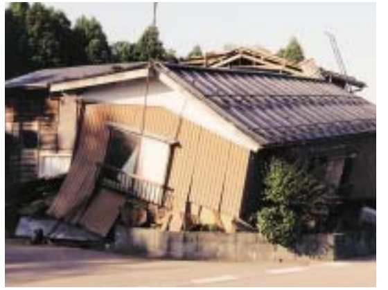
崩れてしまった民家。
