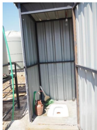
新しく設置されたトイレ
