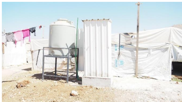
新しく設置された水タンクとトイレ
