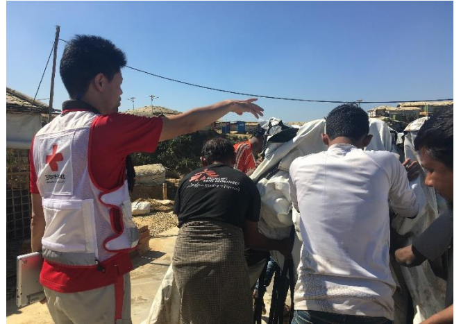
引越しに向けテント解体
