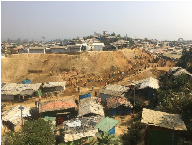
地盤補強工事
