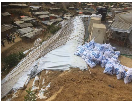
土砂崩れ防止のためのビニールシート敷設
