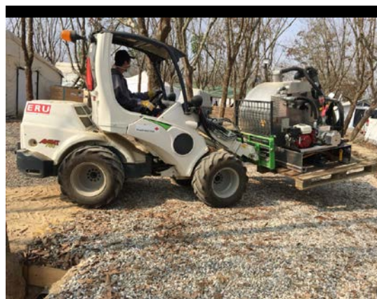
フォークリフトでバキューム装置を移動
