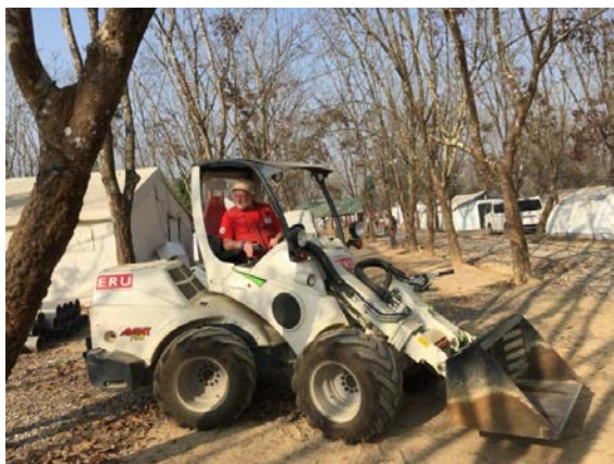
ブルドーザーで雨季対策のための砂利整備
