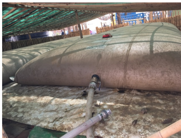
10t 水タンク×2 個で施設の全ての水を供給
