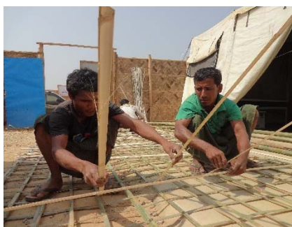
仮説診療所の補強工事をする避難民の方
