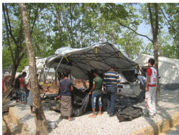
ベースキャンプにオフィステントを設置
