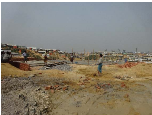
コンクリート敷設 2
