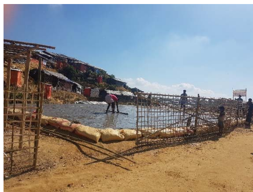
コンクリート敷設 1
