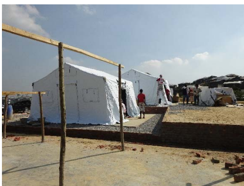
フレームテント設営
