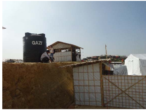
最も高いところに6トンの貯水タンクを設置
