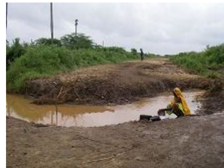
洪水で寸断された道路
