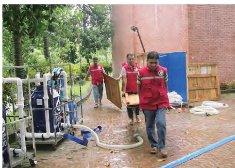
▲日赤が設置した浄水システム
