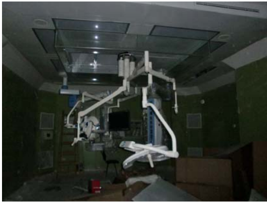
建設中の手術室
